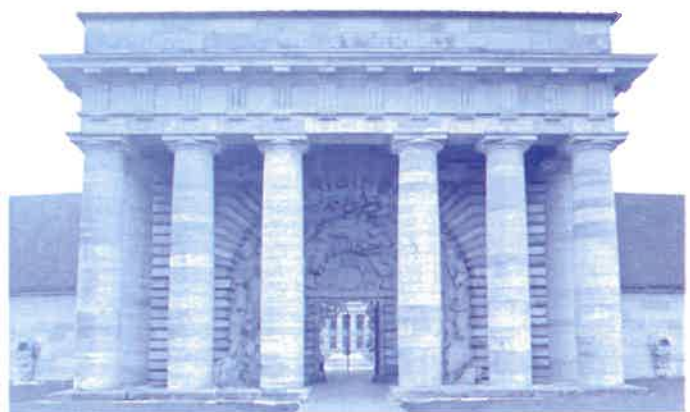
Bâtiment d'entrée de la Saline
